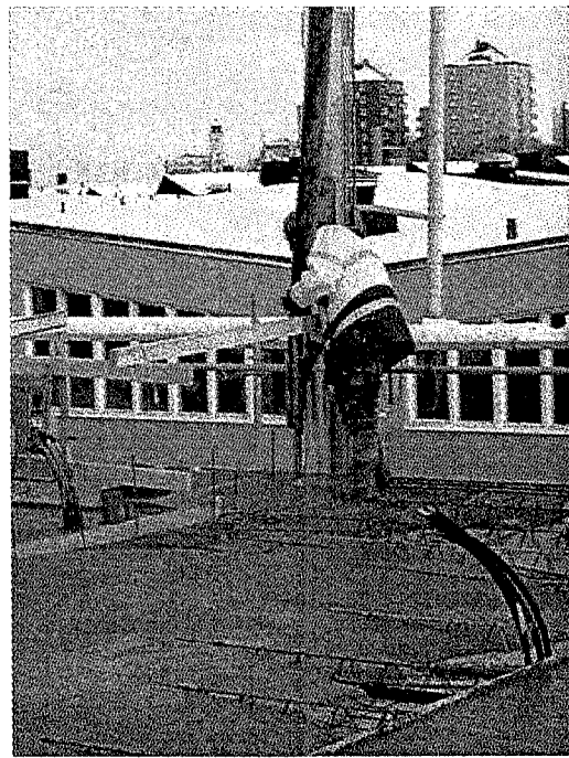
Figur 1b. Självkompakterande betong eliminerar mycket av de vibrationer en betong-arbetare utsätts för.
